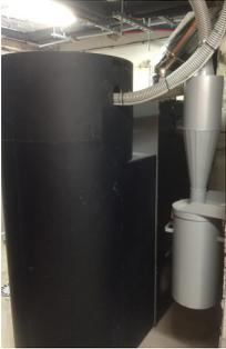
Les logements ont été rénovés afin de limiter au maximum les consommations énergétiques pour les futurs occupants grâce à une chaudière collective à granulés, avec sous comptage pour chaque logement.
